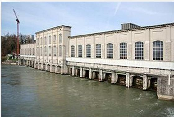
La planta estaba en un recodo del río rhin, en un lugar llamado Beuggen. Las obras de toma, con su vertedero tenían 197.6 metros de largo, El canal de conducción tenía unos 500 metros de longitud hasta la el tanque de reposo antes de la casa de máquinas. Tenía una capacidad de 600 a 1500 m<sup>3</sup>/s.
