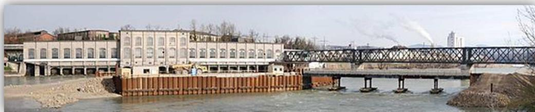
Las unidades operaban con una caída de 4.2 a 6 metros. La casa de máquinas medía 150 metros de largo. (Ver foto arriba). Junto a la casa de máquinas se construyó un puente sobre el río, que como dato curioso tenía una puerta en medio del puente, que podía cerrarse herméticamente, y correspondía a la frontera suiza-alemana.
