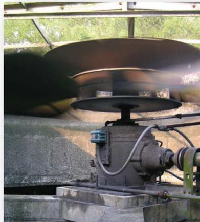
Hemos leído que un fabricante de equipo eléctrico ha diseñado un nuevo motor de velocidad variable, con flecha vertical hacia arriba, capaz de recibir directamente el montaje de las aspas. Este nuevo diseño del motor, y del control de velocidad variable se muestran en las fotos abajo. También se muestra, después, el montaje del motor directamente debajo de las aspas y visto por arriba.
