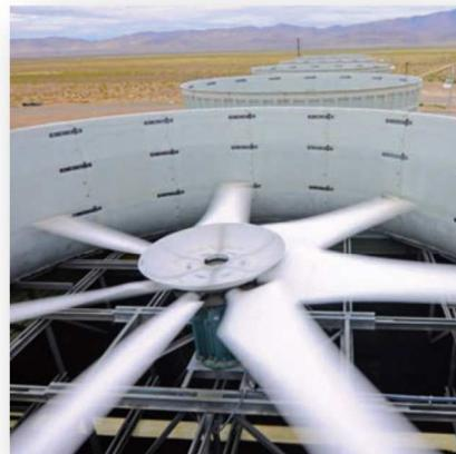
Con este montaje se reducen considerablemente los costos de mantenimiento, así como los costos de operación, pues al tener control de velocidad variable, solamente se usará la energía necesaria para el enfriamiento del agua en cada momento.
