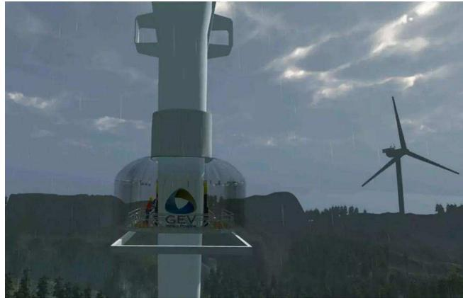
Si el aspa requiere reparación, existen plataformas que se convierten en una caseta inflable, que ajusta perfectamente a la superficie del aspa, quedando al interior de la caseta una atmósfera controlada en temperatura, humedad, etc. necesarias para la reparación.
