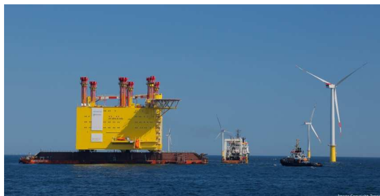
Subestación el alta mar con seis pilotes colocados y listos para colocarlos en el fondo del mar. Los pilotes pintados de rojo.
