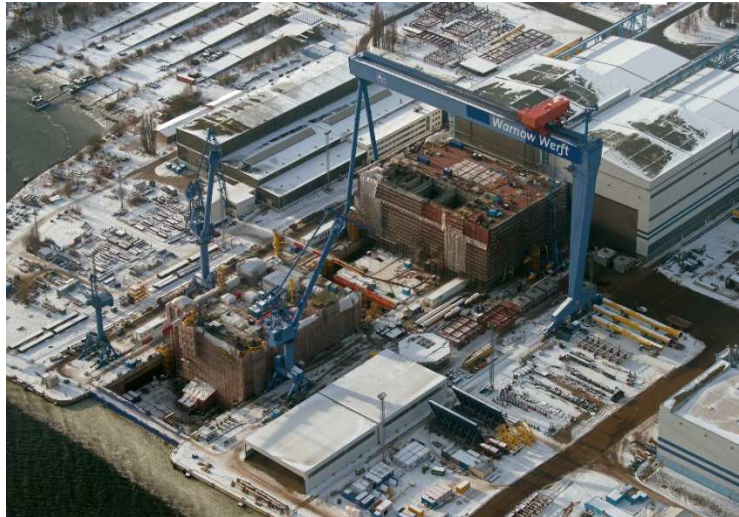
Armado en astillero de una plataforma para subestación en alta mar.
