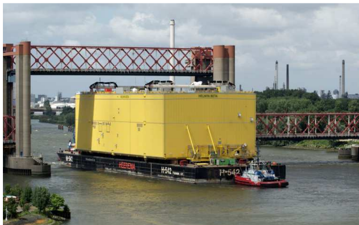
Subestación saliendo del astillero, guiado por remolcadores, rumbo a su destino final.
